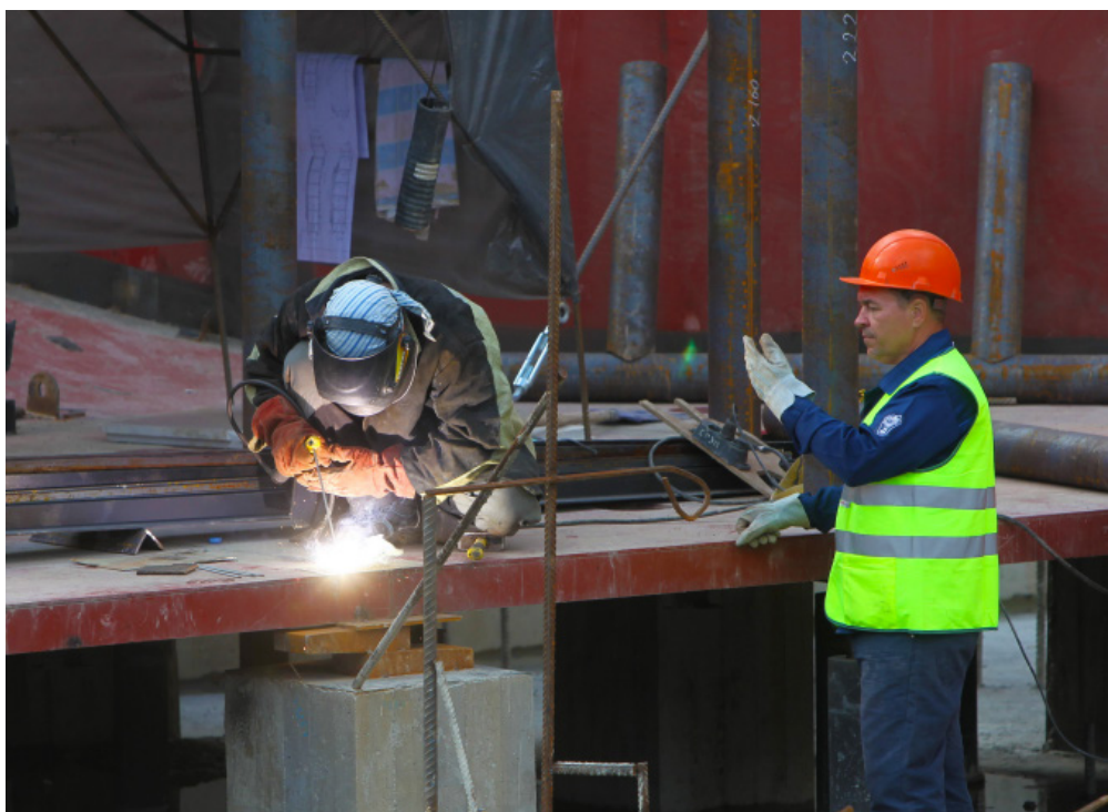
2017年8月15日，俄罗斯西北部卡累利阿共和国凯姆河畔，工人正在别洛巴罗什水电站施工现场工作。这是俄罗斯首个由金砖国家新开发银行提供融资支持的项目。（新华社图片）
